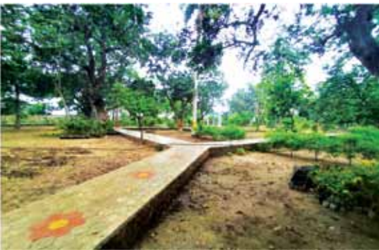
निर्माणाधीन सिमरौनगढ वनस्पति उद्यान, बारा
